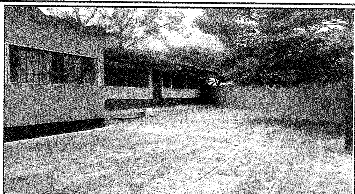
Foto 2: Muro, instalacion de laminas troqueladas en aulas, piso en corredor y pintura terminada en proyecto de remozamiento
