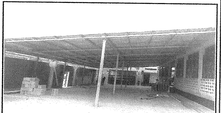
Foto 6: Ampliación de galera terminada.
