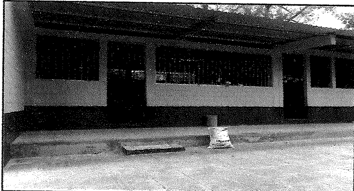
Foto 3:Aula y corredor terminada despues de la sustitución de techo, asi mismo cambio de piso terminado en corredor de las dos aulas.
