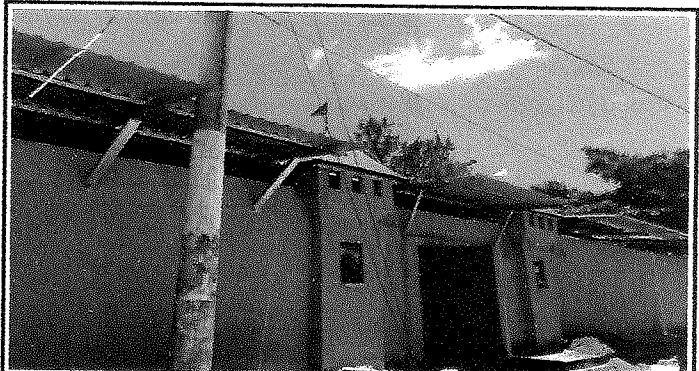
Foto 4: Reparacion de Muro, pintura, ampliacion de galera terminada
